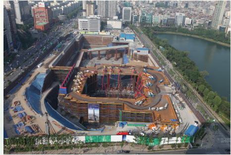
잠실 롯데 슈퍼타워 기초매트 타설 장면
