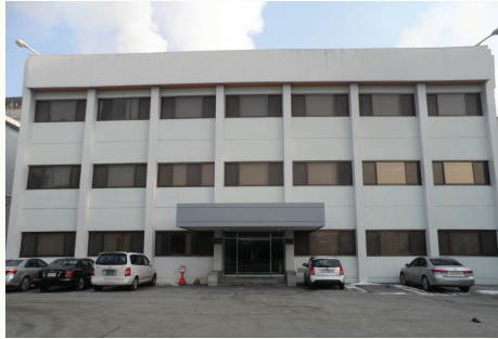
아세아시멘트 기술연구소 전경
